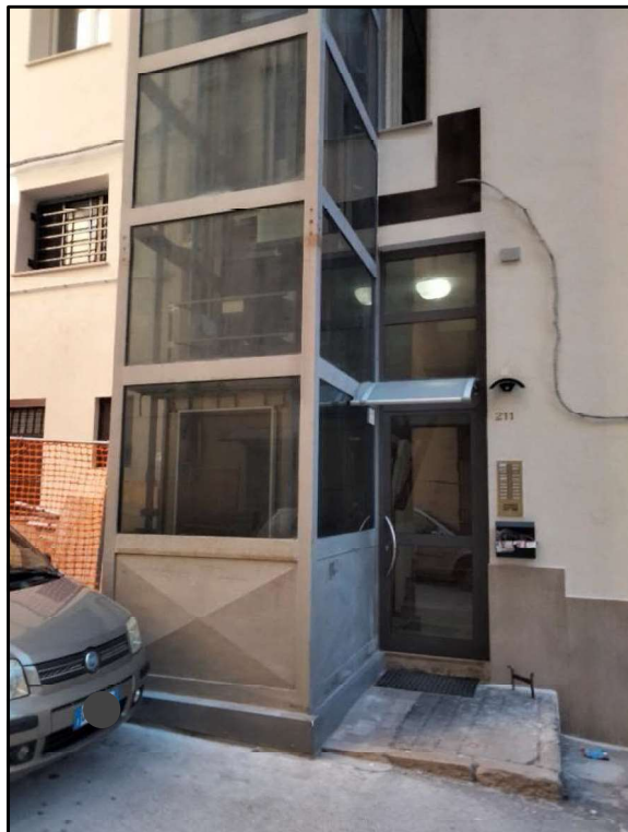
Particolare Ascensore esterno
